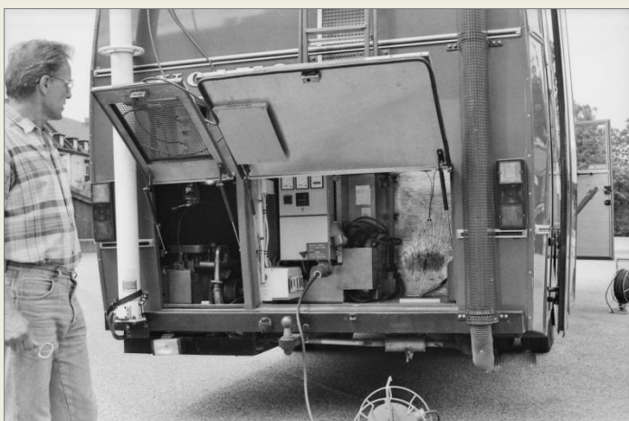
Elgenerator 10 kW/380 V i vänstra och elcentral i högra skåpet.
